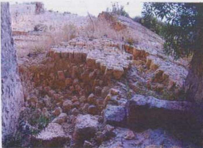
Bild 7: Talsperre „Eisernes Tor“: unterer Teil des stark beschädigten Mauerbogens
