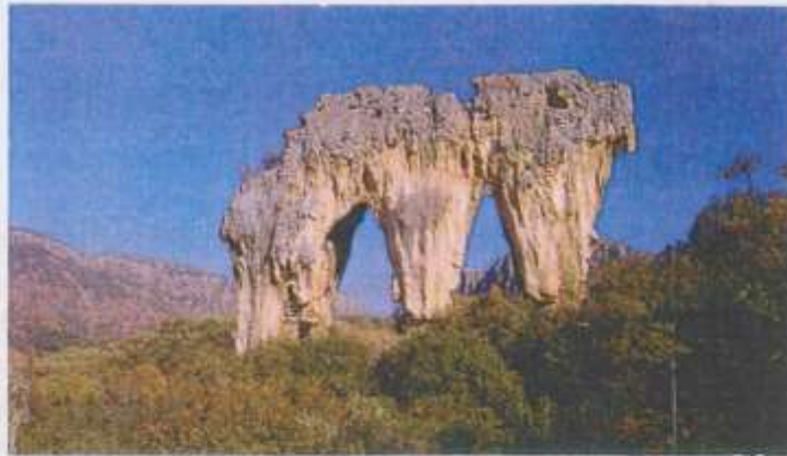
Bild 2: Von Sinter überdeckte Ruine der Kantara-Brücke
